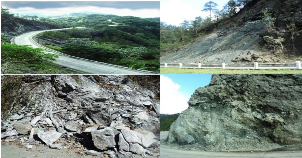
Figura 21. Deslizamiento del Viaducto La Farola.
